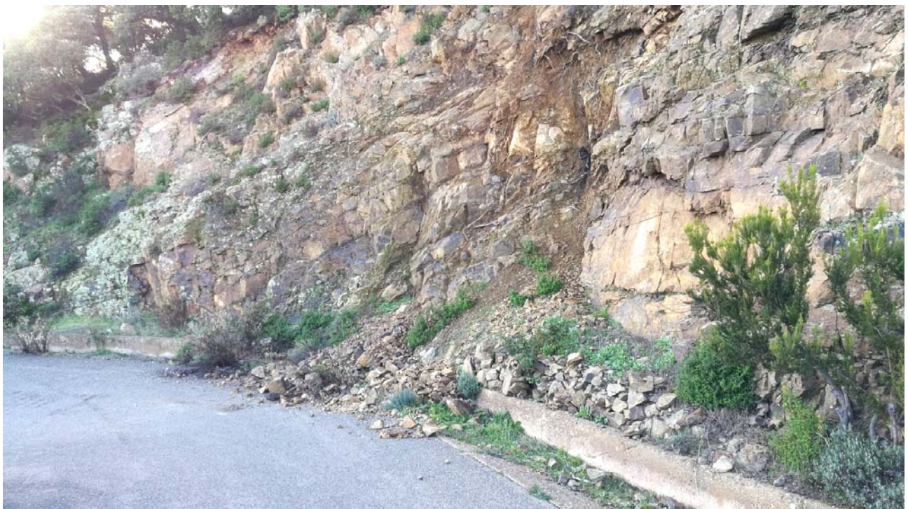
Foto – Strada Comunale Fluminera - Genna Frocciddaras - Coxinas
